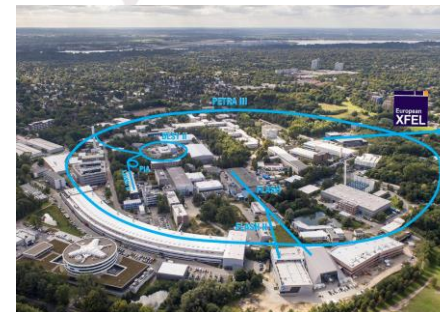
DESY (ドイツ電子シンクロトロン) ・ 15年以上の稼働実績 ・ LINIAC (直線加速器) スペクトラム社の最新モデルに 置き換え
